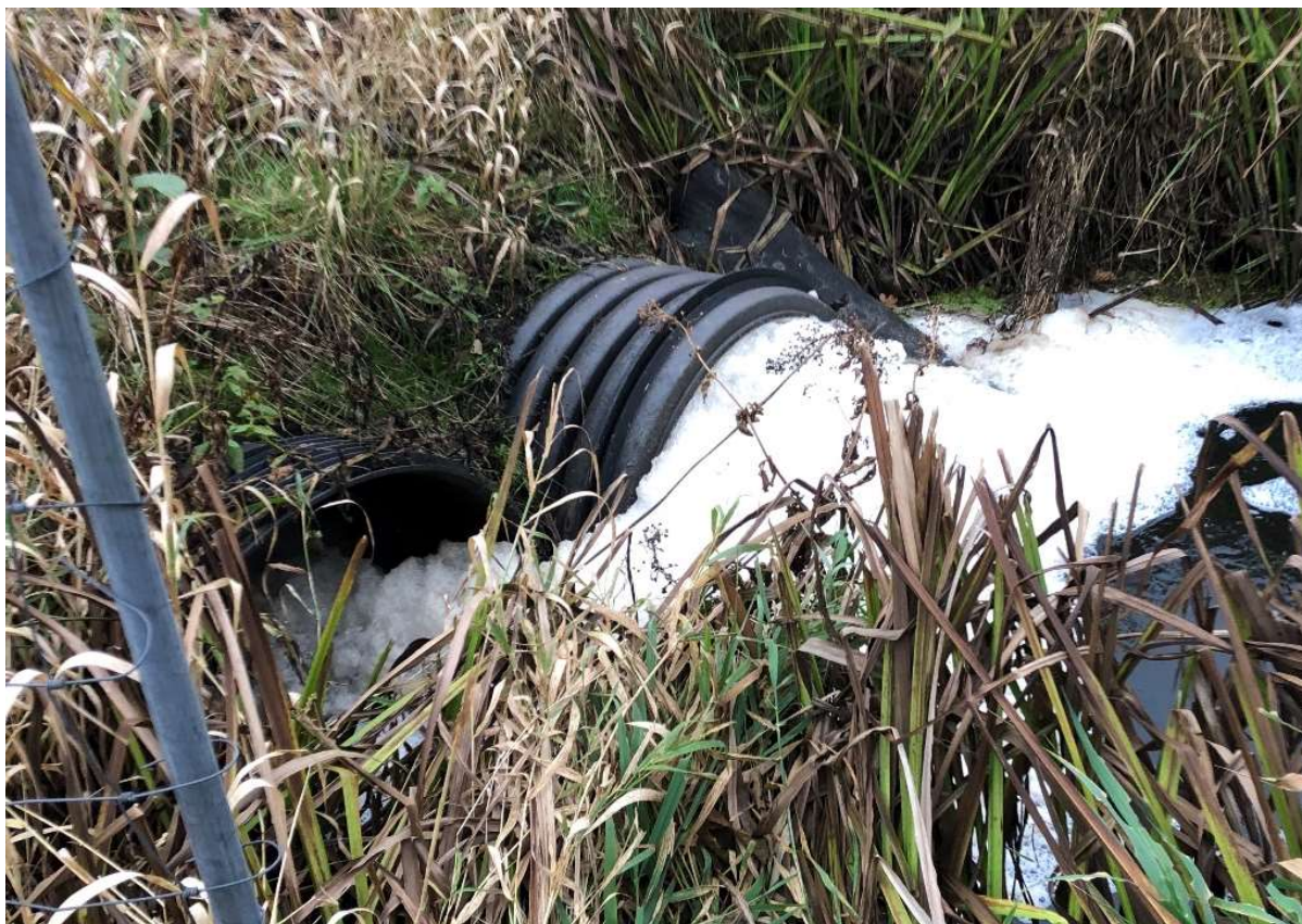
Figur 2.4 Dobbelt rørbro ved Gl. Lindved Å, reg. st. 23.
