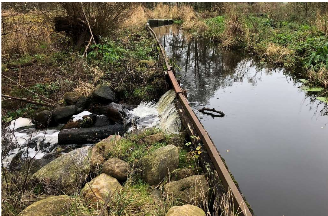
Figur 1.4 Overfaldskant ved Lindved Å, hvor spjæld ses i centrum. I billedets venstre side ses større kampesten, der sikrer skråningen når overfaldet træder i funktion.
